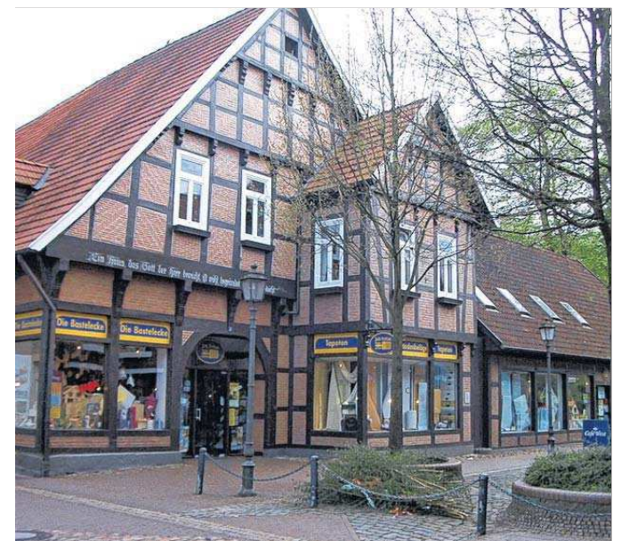
Das älteste Gebäude der Stadt Fürstenau beherbergt das Malergeschäft Fritze. Fotos: Jürgen Schwiwter
