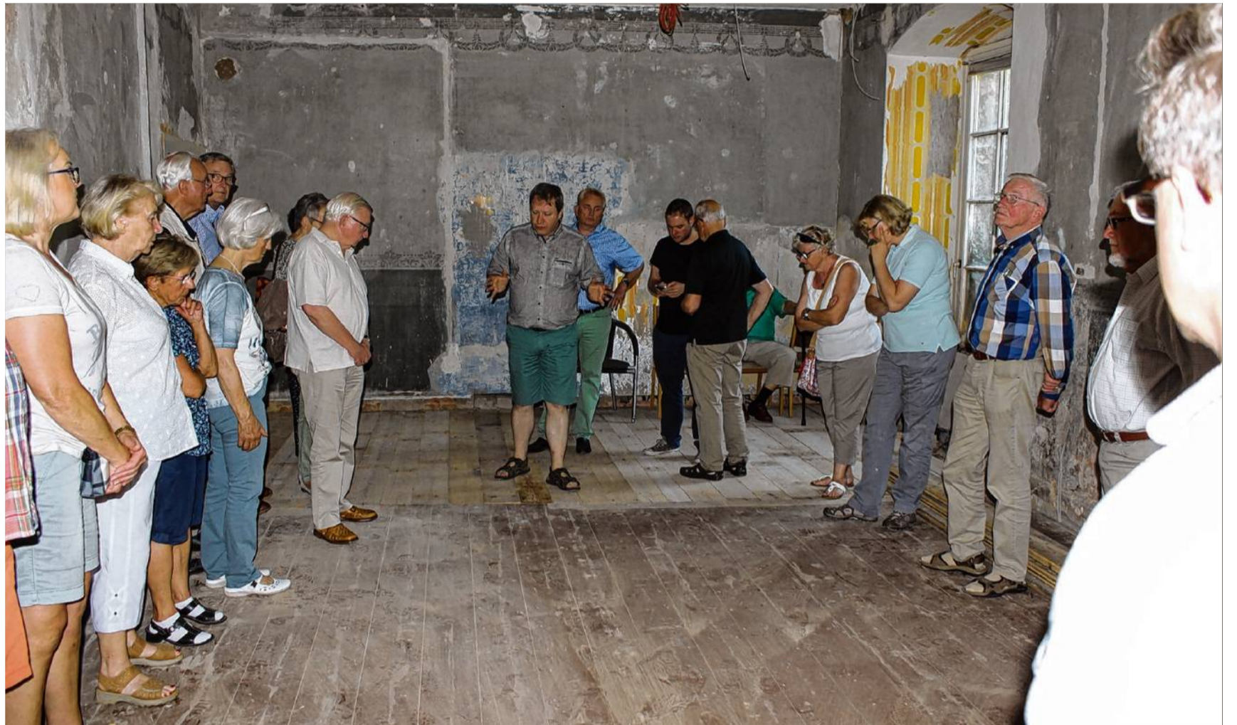
In der ehemaligen Hausmeisterwohnung sind die Arbeiten schon weit fortgeschritten, Arnold Beuke (Bildmitte) gab dazu Erläuterungen. Foto: Franz Buitmann
