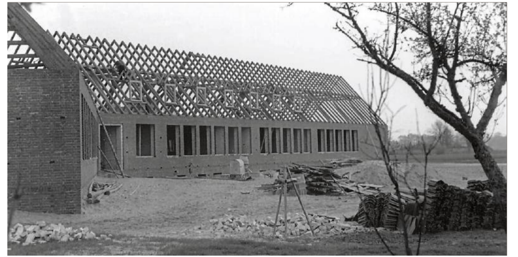
Die Bauarbeiten dauerten zwei Jahre.
