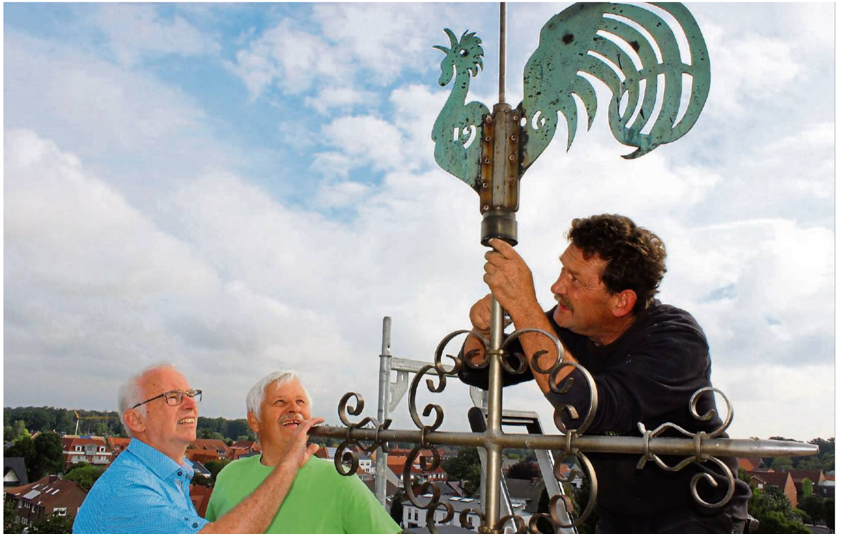
Bei der Demontage des Wetterhahns überwachte Jörg Weissenborn (Mitte) vom Kirchenvorstand die Arbeiten.
