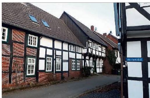
Das Fachwerkhaus im Hintergrund ist das Haus Kramer.
