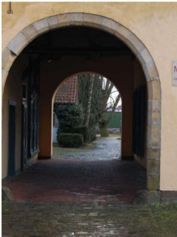
In der Durchfahrt könnten neue Eingänge untergebracht werden.
