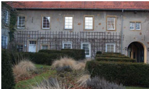
Der Erdgeschossflügel neben der Durchfahrt wird bislang als Magazin genutzt. Hier sollen zusätzliche Räume für das Museum entstehen. Im Vordergrund einer der Friedensgärten, die 1998 aus Anlass des Jubiläum „350 Jahre Westfälischer Frieden“ im Osnabrücker Land entstanden. Foto: Martin Schmitz
