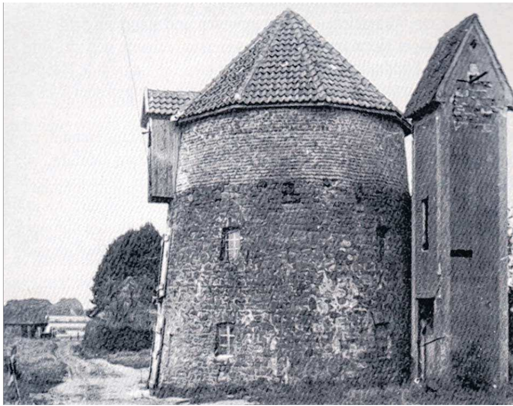
Nur noch Teile der Umfassungsmauern sind von der Eymannschen Mühle im Heeker Esch vorhanden. Diese Ansicht entstand im Jahr 1953.
