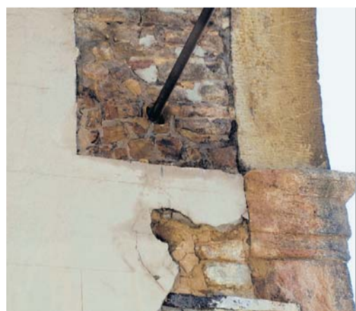
Zugstangen sind aus Stabilitätsgründen eingebaut worden.
