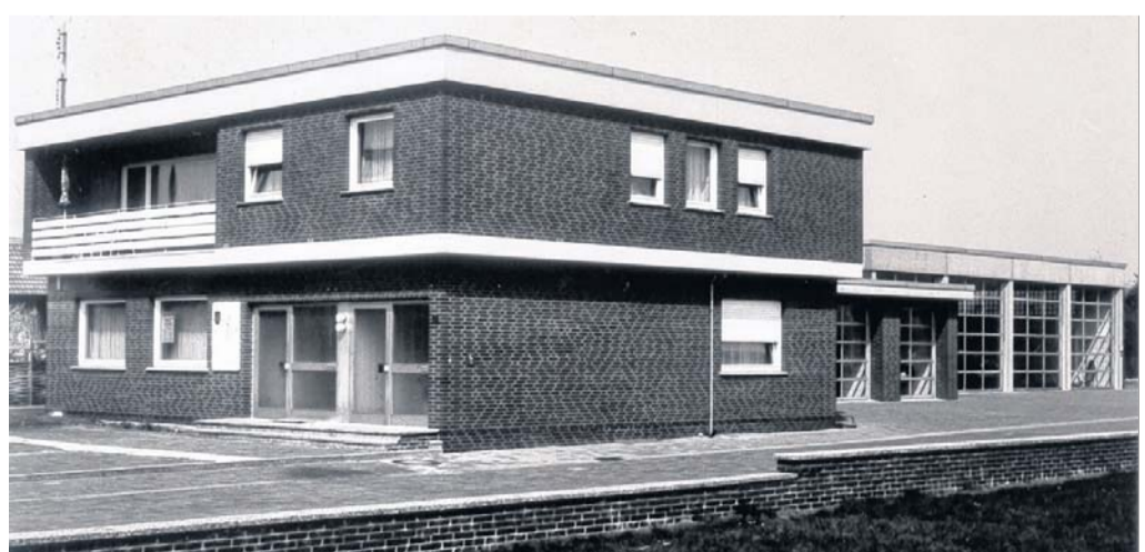
Das 1974 erbaute Feuerwehrhaus ist noch immer das Domizil der Blauröcke. Repros: Jürgen Schwietert
