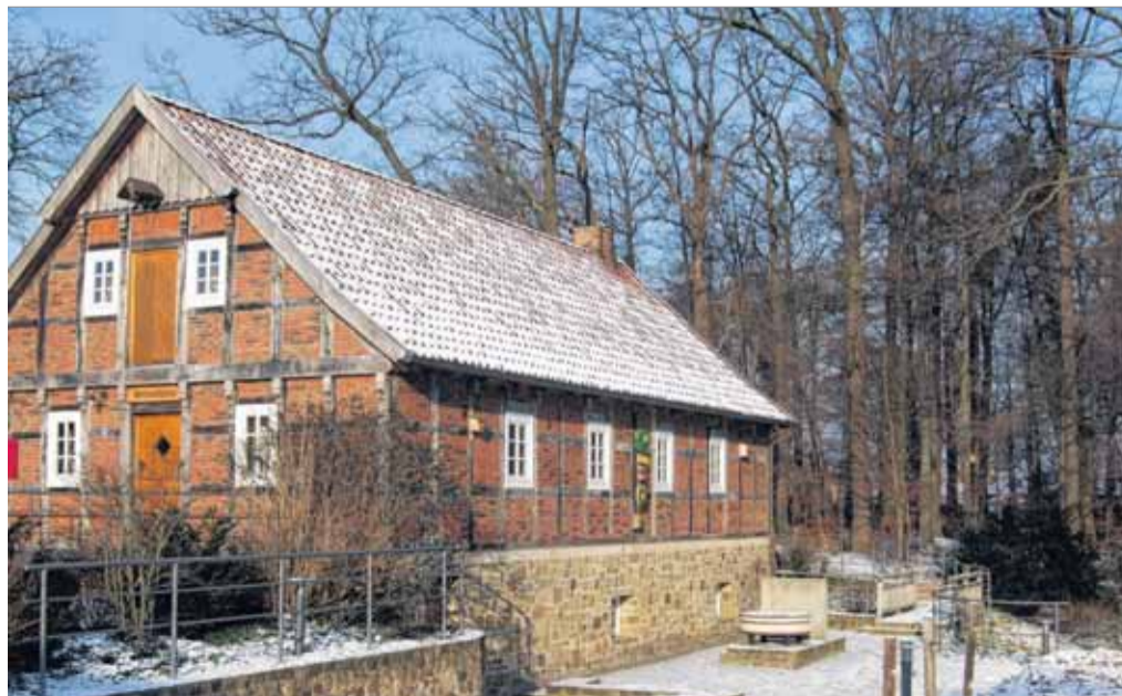
Das Heimathaus „Feldmühle“ ist das Domizil des Heimatvereins Bersenbrück. Es handelt sich um eine alte Mühle des Klosters. Fotos: Franz Buitmann
