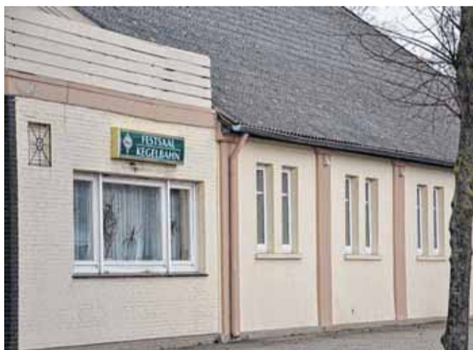
Im Saal der Gastwirtschaft Welling waren Klassenräume untergebracht.
