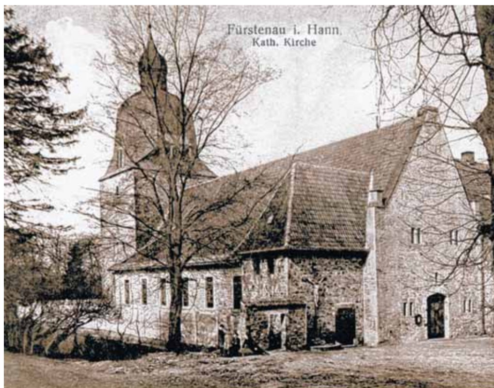
Die Schlosskirche in Fürstenau: Diese Postkarte zeigt eine Ansicht aus dem Jahr 1925, hier mit dem neuen Seitenschiff.
