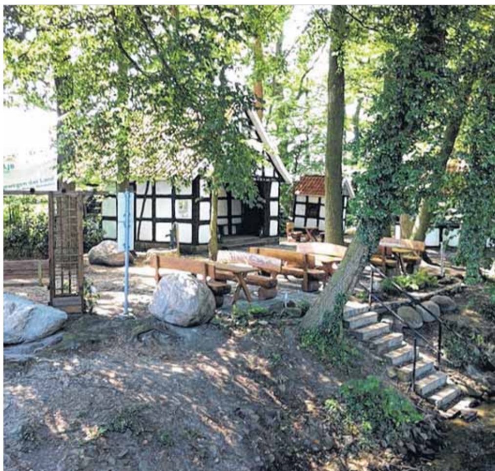
Die Wetterschutzhütte an der Voltlager Aa.
