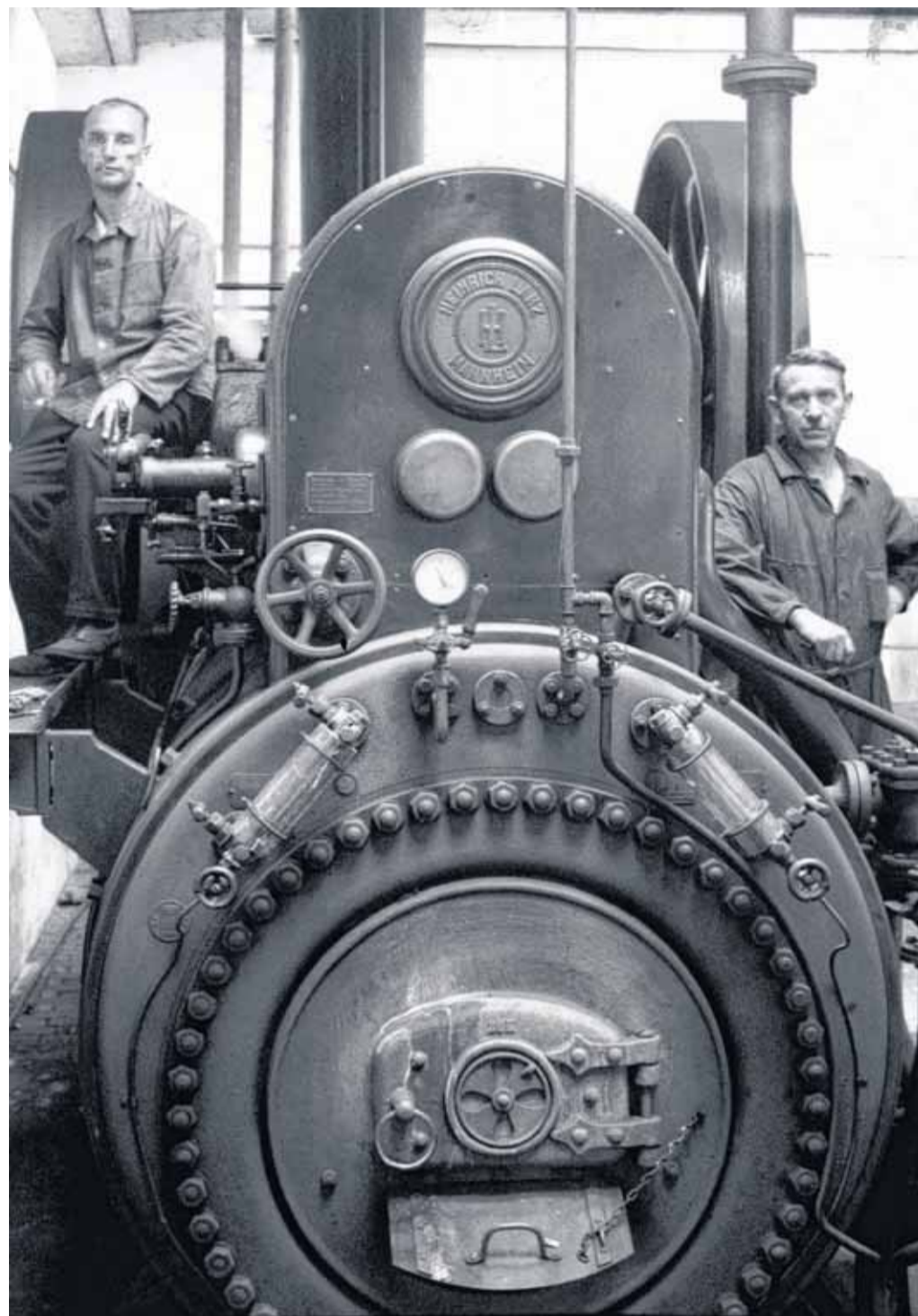
Die Lanz-Dampf-Lokomobile in der Tuchmacher-Innung diente zur Dampfzeugung und zum Antrieb der Transmissionsriemen. Links im Bild: Herrmann Aulfes, rechts Heinrich Möllmeyer, die „Männer für alle Fälle“ bei technischen Defekten (ca. 1918). Foto: Archiv Gottlieb
