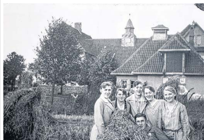
Das neue Schulgebäude hatte sogar einen Turm, der allerdings 1931 wegen Undichtigkeit entfernt werden musste.
