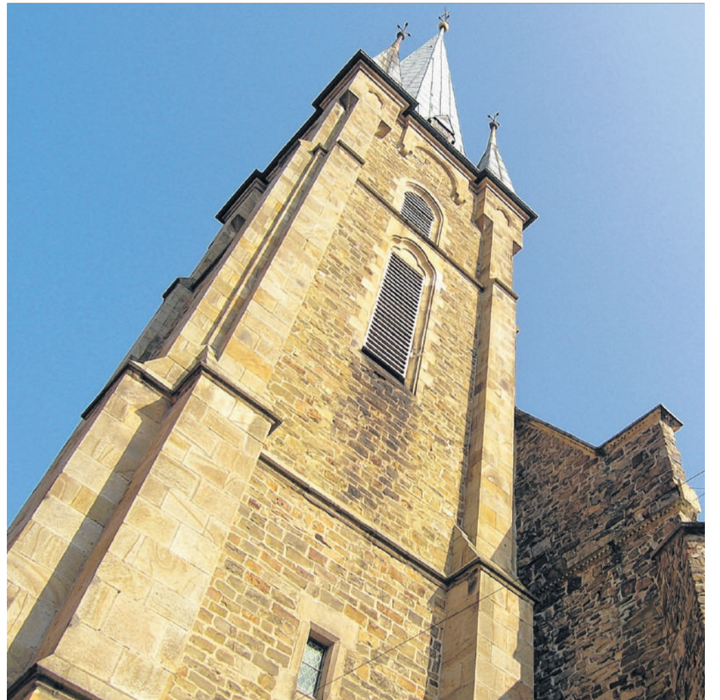
Der Turm von St. Georg entstand zwischen 1896 und 1899.
