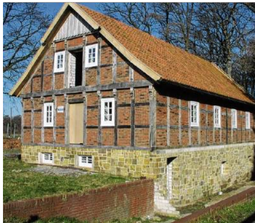
Die Feldmühle während der Renovierungsphase.
